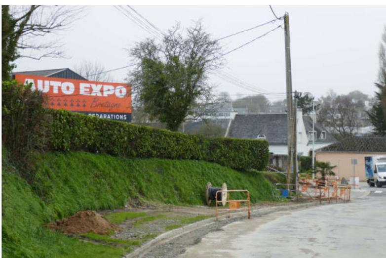
► Les travaux d'effacement des réseaux aériens ont commencé : terrassement pour le passage de câbles, et dépose de la ligne France Telecom au rond-point du boulevard du Ponant.
