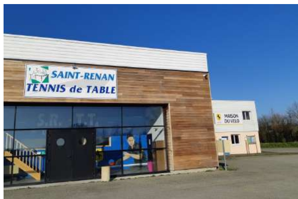
► Nettoyage et Peinture du hall des bâtiments et du bureau du tennis de table
