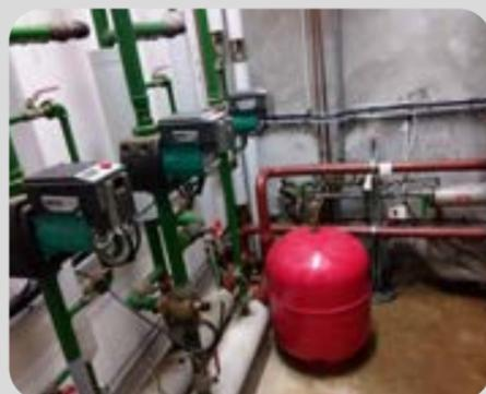
**La rénovation de la chaufferie de la médiathèque a été réalisée.** En effet, les deux chaudières existantes ont été remplacées par des chaudières à haut rendement économes en énergie. De plus, le remplacement du système de régulation a été effectué pour une meilleure gestion du chauffage dans le bâtiment. Le montant de ces travaux s'élève à 23 921€ TTC et ont été réalisés par l'entreprise OSC.
