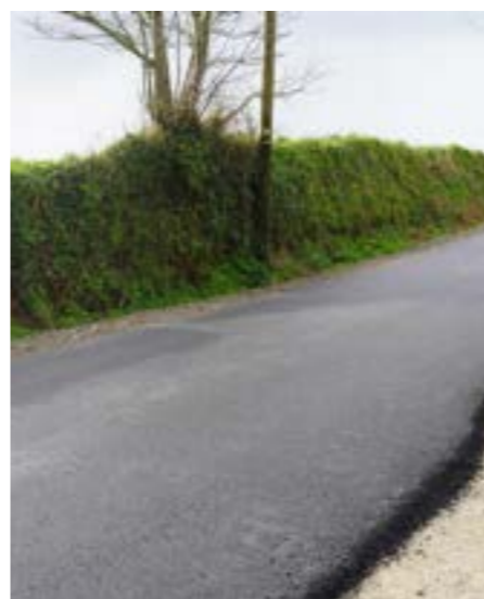
Route de Keredec Réfection de la chaussée et enfouissement de réseaux
